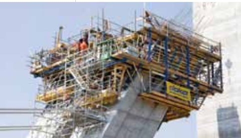
▲ 16 tongadas de 2,10 m con encofrado autotrepante SKE 50.
