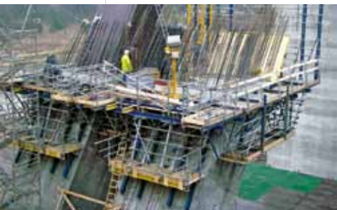
▲ Pilas con una inclinación de 33° sobre la vertical.
